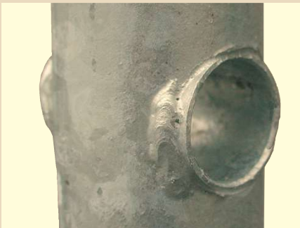
Hülse für stabile Aufhängung der Augenschrauben
