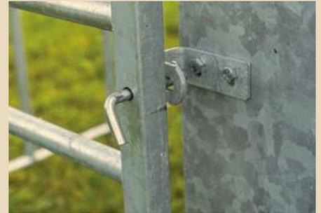
Sicherung des Kälberschlupfes durch zwei Bolzen
