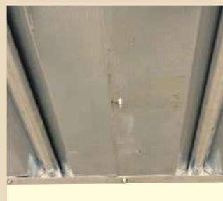
Doppelte Verstärkungsrohre unter dem Bodenblech
